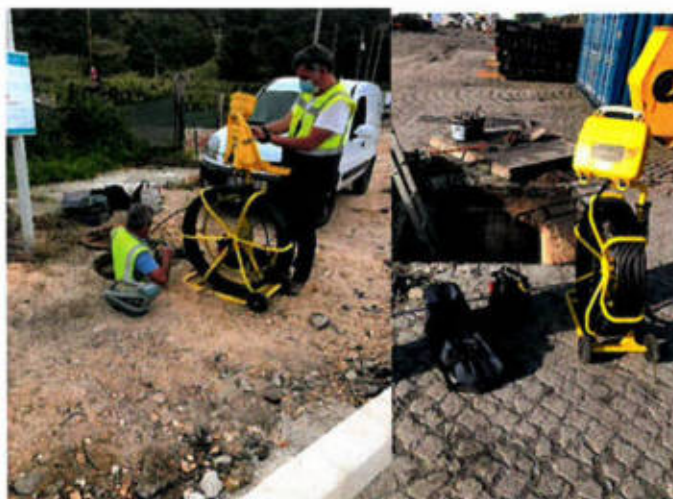
Figura 5 - equipamento de sondagem com CCTV incorporado para inspeção e deteção de infraestruturas
