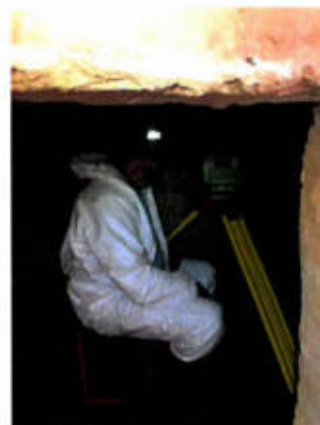
Figura 3 - levantamento de precisão no interior de infraestruturas de drenagem
